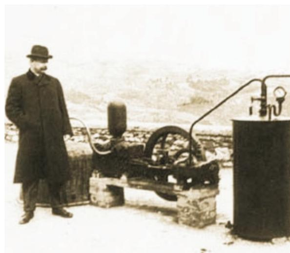
**Рис.1.** Устройство, использованное в Лардерелло в 1904 г. в первом в мире эксперименте по производству электроэнергии из геотермального пара, и его изобретатель Пьеро Джинори Конти
