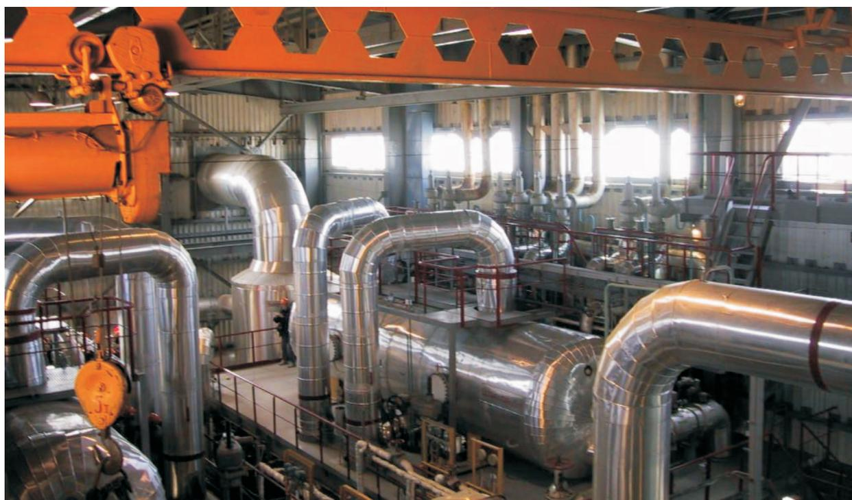
Рис.4. Мутновская ГеоЭС. Сепараторный зал (Фото В. Сваловой)
